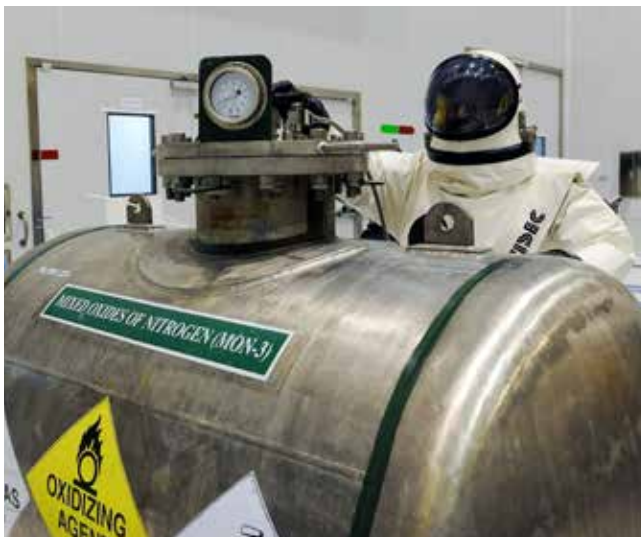
Opération de remplissage en ergol d'un satellite
