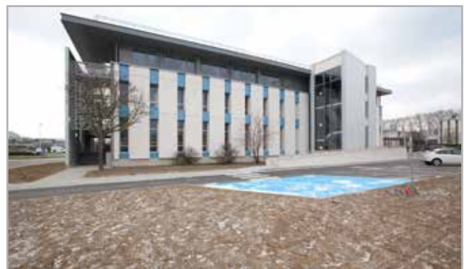
- Rénovation du bâtiment Jean-Bernard Dementhon - Dementhon est le premier bâtiment du CST à être réhabilité selon une démarche Haute Qualité Environnementale (HQE). Il met en pratique les concepts du projet « Le CST de demain »
