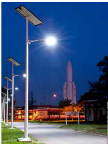
Lampadaire solaire installé au CSG.
