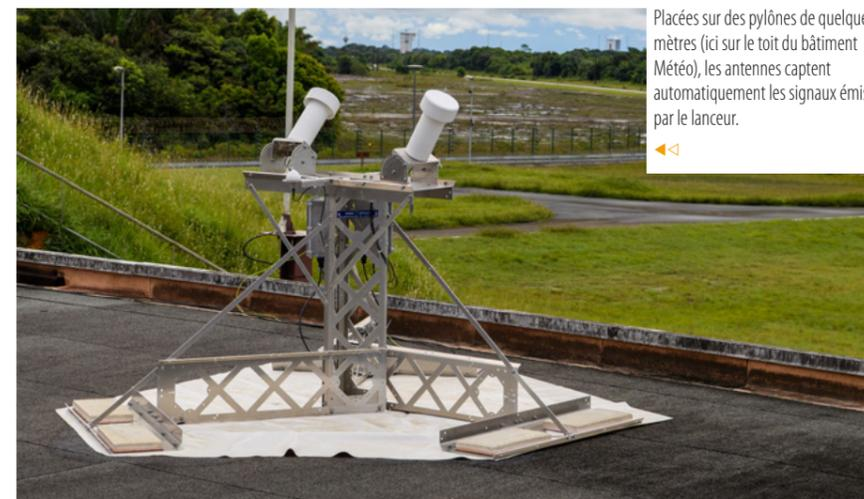
Placées sur des pylônes de quelques mètres (ici sur le toit du bâtiment Météo), les antennes captent automatiquement les signaux émis par le lanceur.
