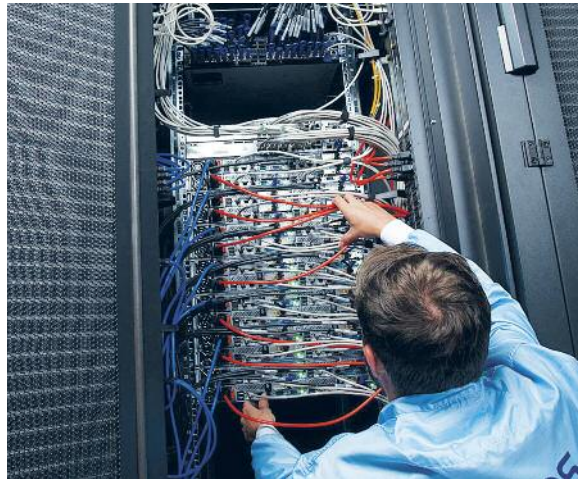
◀ Baies de stockage informatique de la mission Gaia. Data storage arrays for the GAIA mission.
