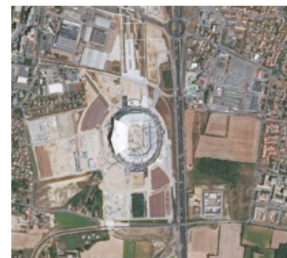
Construction du grand stade de Lyon.
