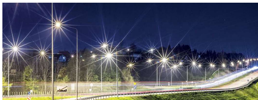
Exemple d'éblouissement et de sur-éclairage
